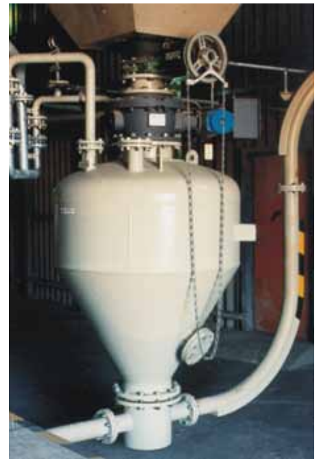
Пневмокамерный насос подвешенный под бункером электрофилтра
